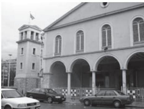
Εικ. 2. Δυτική άποψη του ναού.
