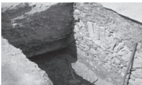
Εικ. 6. Εξωτερική διερευνητική τομή στην μεσημβρινή τοιχοδομή.
