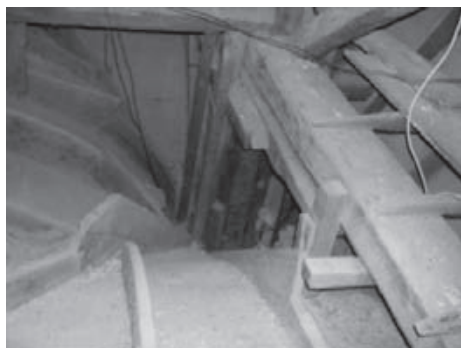
Εικ. 3. Σύνθετοι ξύλινοι στύλοι στηρίζουν την στέγη
