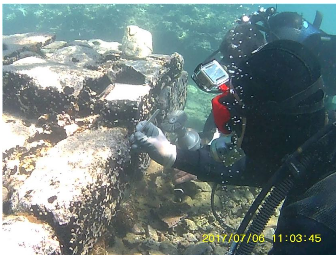
Εικ. 4. Εργασίες συντήρησης σε τείχο της ρωμαϊκής έπαυλης στο πλαίσιο του εκπαιδευτικού προγράμματος του 2017 (φωτ. Παναγιώτα Γαλιατσάτου).
