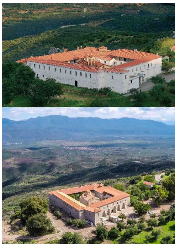
Εικ. 11. Αποκατάσταση Νέας Μονής Βουλκάνου (φωτ. ΕΦΑΜΕΣ).
