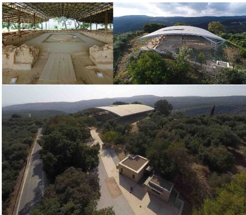
Εικ. 1. Κατασκευή νέου στεγάστρου, προστασία και ανάδειξη Ανακτόρου Νέστορος (φωτ. ΕΦΑΜΕΣ).
