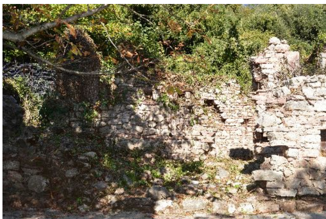
Εικ. 9. Μονή Καλαμίου. Από τις εργασίες καθαρισμού της βόρειας και δυτικής πτέρυγας (φωτ. ΕΦΑΑΡΚ).
