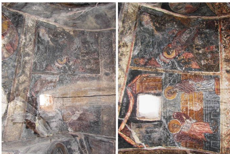
Εικ. 9. Το νότιο τμήμα του θόλου του ιερού πριν και μετά τις εργασίες συντήρησης.
