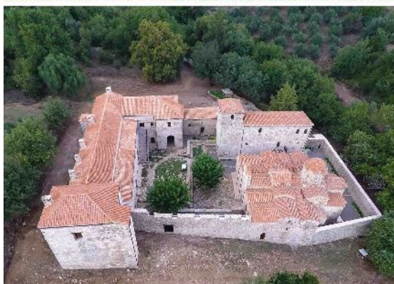
Εικ. 3. Αποκατάσταση Μονής Μεταμορφώσεως του Σωτήρος (Ανδρομονάστηρο) (φωτ. ΕΦΑΜΕΣ).
