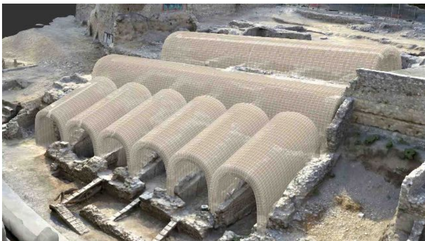
Εικ. 2. Τρισδιάστατη αναπαράσταση του Σταδίου με δήλωση των θόλων των κερκίδων (ΕΦΑΑΧΑ).
