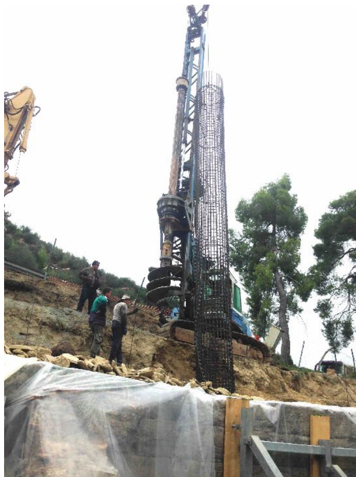
Εικ. 1. Κρόνιος λόφος, άποψη κατά τη φάση εργασιών, τοποθέτηση πασάλων (Αρχείο ΔΑΑΜ).
