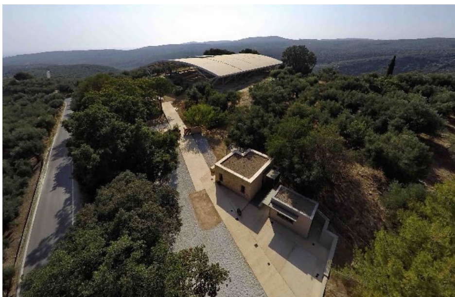
Εικ. 6. Το αναψυκτήριο, το κτήριο πληροφόρησης/πωλητήριο και η διαδρομή περιήγησης προς το στεγασμένο Ανάκτορο του Νέστορος (φωτ. ΕΦΑΜΕΣ).
