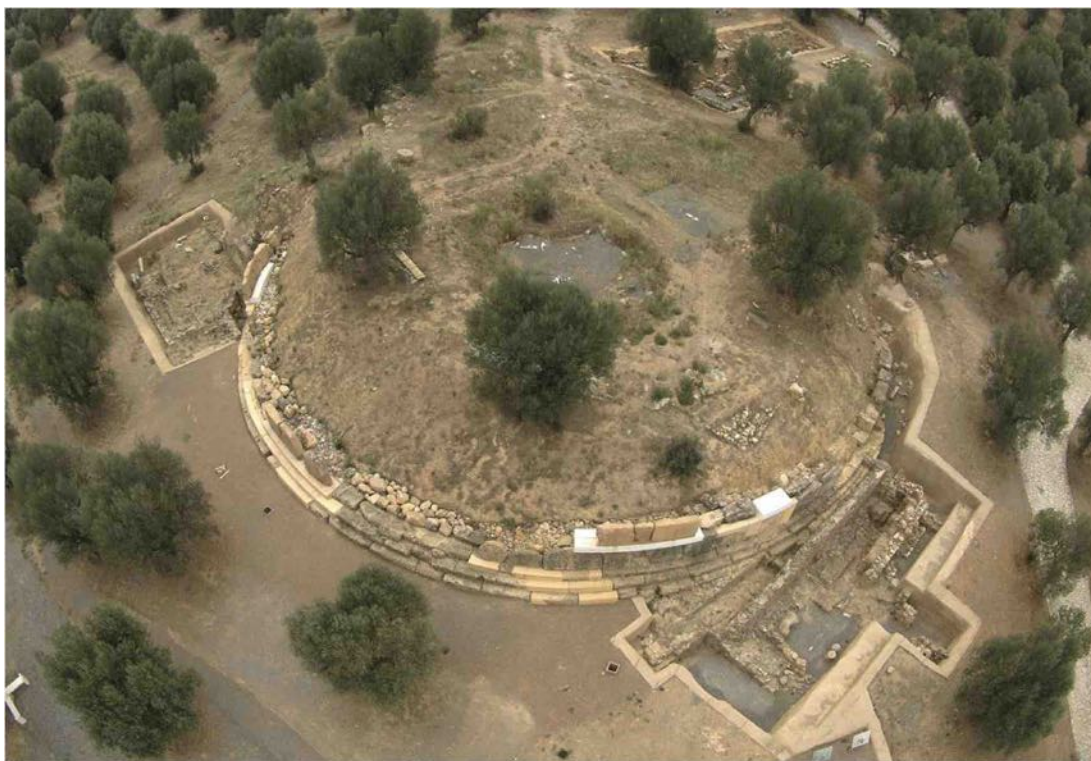
Εικ. 7. Γενική άποψη του μνημείου μετά τις εργασίες αναστήλωσης και ανάδειξης του περιβάλλοντος χώρου (φωτ. Β. Γεωργιάδης).
