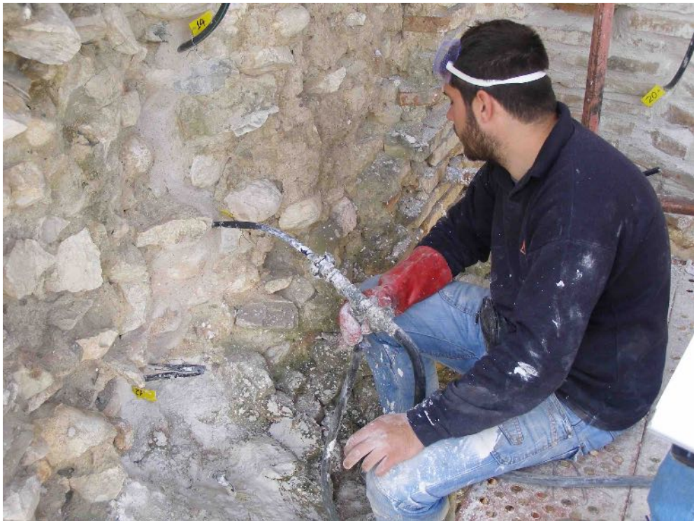
Εικ. 7. Εισπίεση ενέματος (φωτ. Εφορεία Αρχαιοτήτων Αχαΐας).
