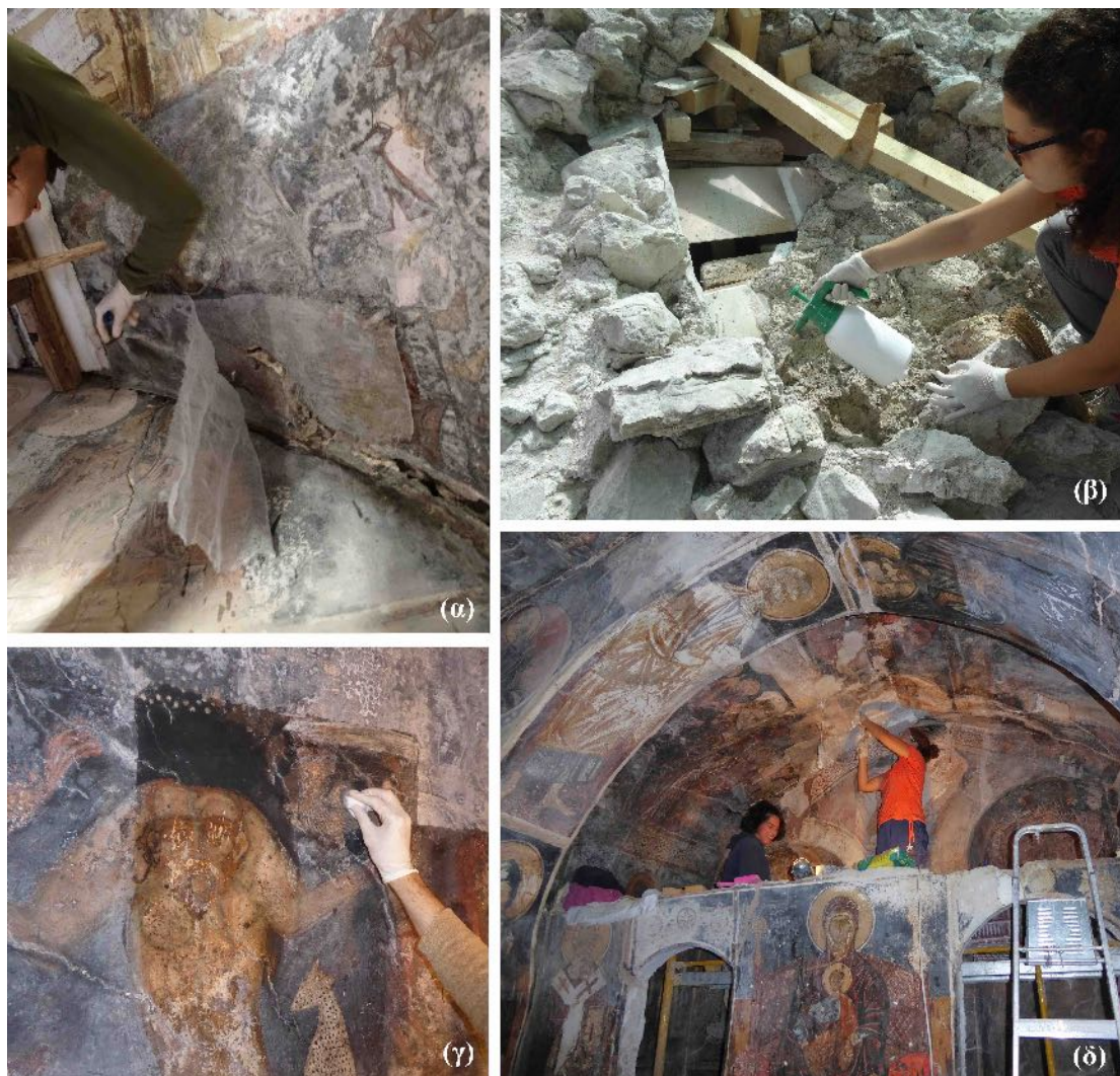
Εικ. 3. Εργασίες συντήρησης των τοιχογραφιών: α) οπλισμός της ζωγραφικής επιφάνειας, β) στερέωση του υποστρώματος από την εξωτερική πλευρά του θόλου στο ιερό, γ) καθαρισμός της ζωγραφικής επιφάνειας, δ) εργασίες συντήρησης στον θόλο του ιερού.
