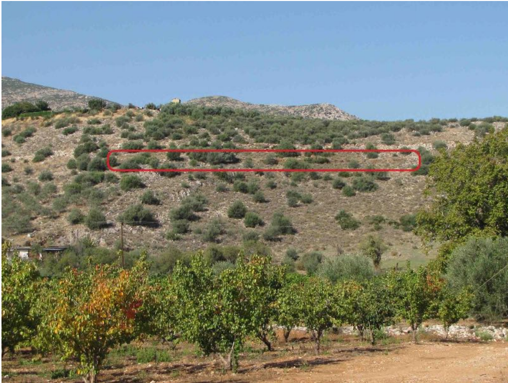
Εικ. 3 . Η πορεία του Αδριάνειου Υδραγωγείου στο ύψωμα Τσούκα Σταθείων (φωτ. ΕΦΑΑΡΓ).
