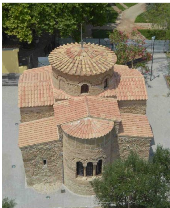
Εικ. 8. Καθολικό Μονής Φραγκαβίλλας. Μετά την ολοκλήρωση των εργασιών αποκατάστασης (φωτ. Αρχείο ΕΦΑΑΧΑ).
