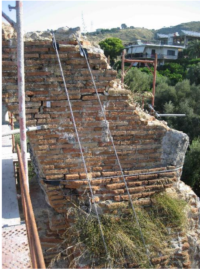
Εικ. 5. Περιδέσεις με συρματόσχοινα στην απόληξη του εναπομείναντος τμήματος άνω τόξου για τη συγκράτηση των προς αποκόλληση όγκων (φωτ. Μ. Μεντζίνη).
