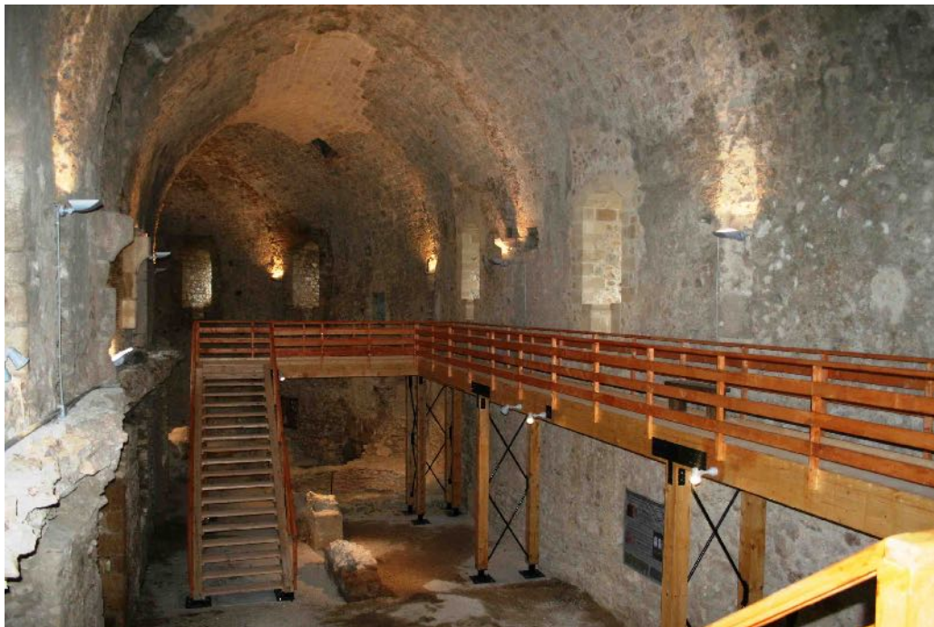
Εικ. 6. Κάστρο Χλεμούτσι. Η Αίθουσα Α2 μετά την ολοκλήρωση του έργου αποκατάστασης και ανάδειξης (φωτ. Α. Κουμούση).
