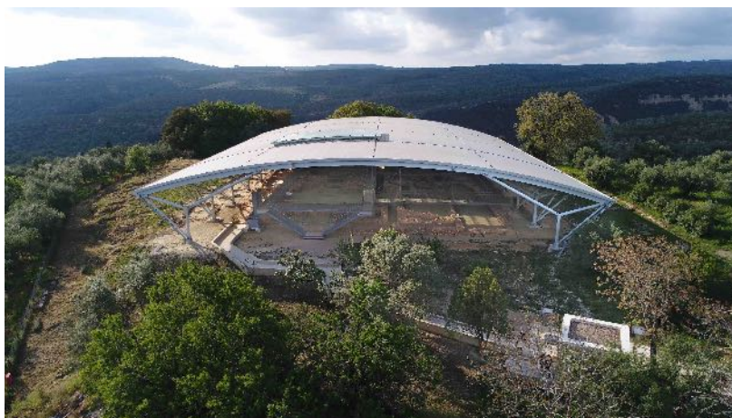
Εικ. 2. Το Ανάκτορο του Νέστορος με το νέο στέγαστρο προστασίας και τις αναβαθμισμένες υποδομές εξυπηρέτησης κοινού (φωτ. ΕΦΑΜΕΣ).
