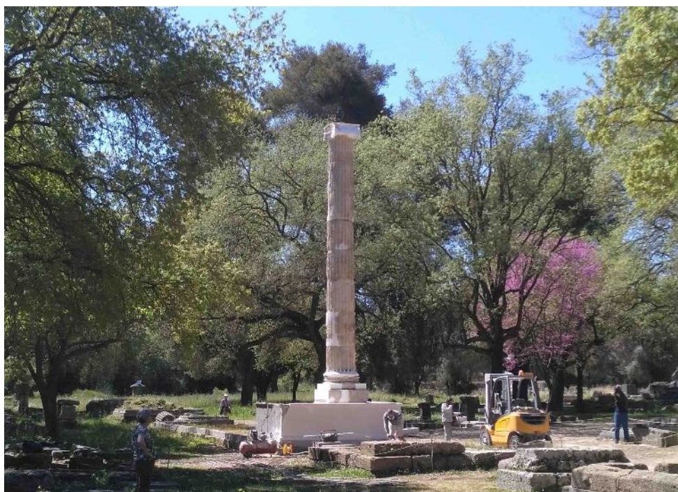
Εικ. 2. Αρχαιολογικός Χώρος Ολυμπίας: ο βόρειος κίονας του μνημείου του Πτολεμαίου Β' και της Αρσινόης κατά τις εργασίες αναστήλωσης (Αρχείο ΕΦΑΗΛ).
