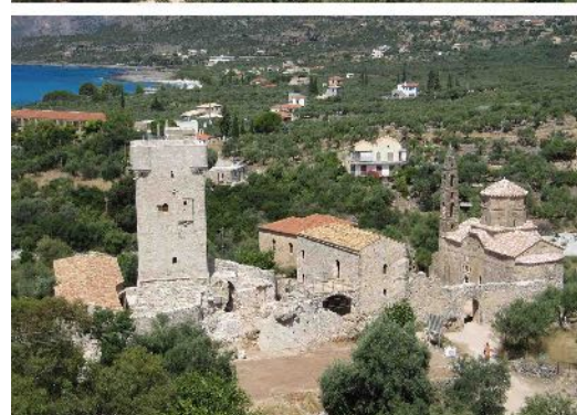
Εικ. 14. Αποκατάσταση οχυρού συγκροτήματος Τρουπάκηδων Καρδαμύλης (φωτ. ΕΦΑΜΕΣ).
