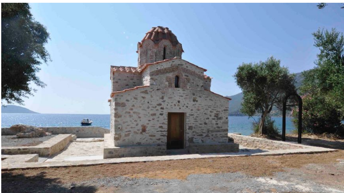
Εικ. 6. Αγία Βαρβάρα Σκουταρίου. Άποψη από δυτικά, μετά τις εργασίες (φωτ. ΕΦΑΛΛΑΚ).
