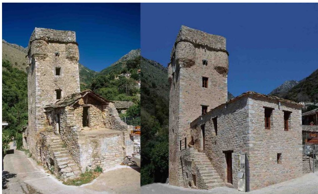
Εικ. 10. Αποκατάσταση Πύργου Δουράκη Καστάνιας (φωτ. ΕΦΑΜΕΣ).
