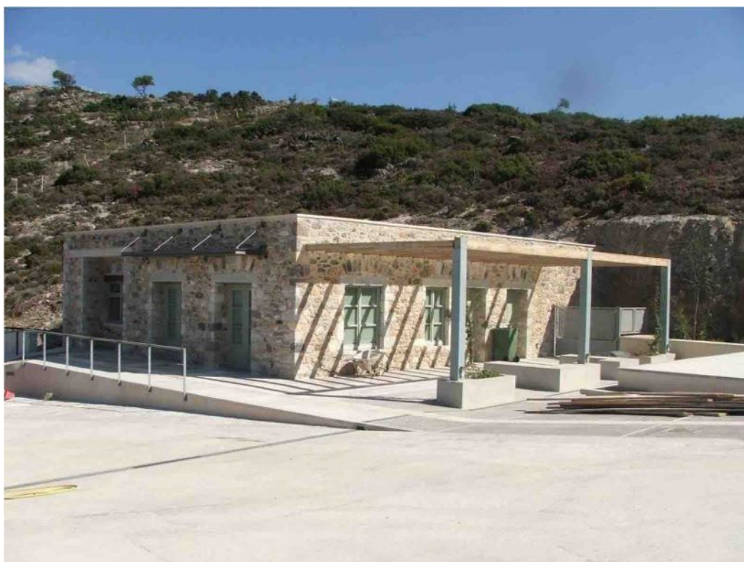
Εικ. 10. Κάστρο Γερακίου. Κτήριο υποδοχής επισκεπτών από νοτιοδυτικά μετά τις εργασίες (φωτ. Ε. Ελευθερίου, Αρχείο ΕΦΑΛΑΚ).
