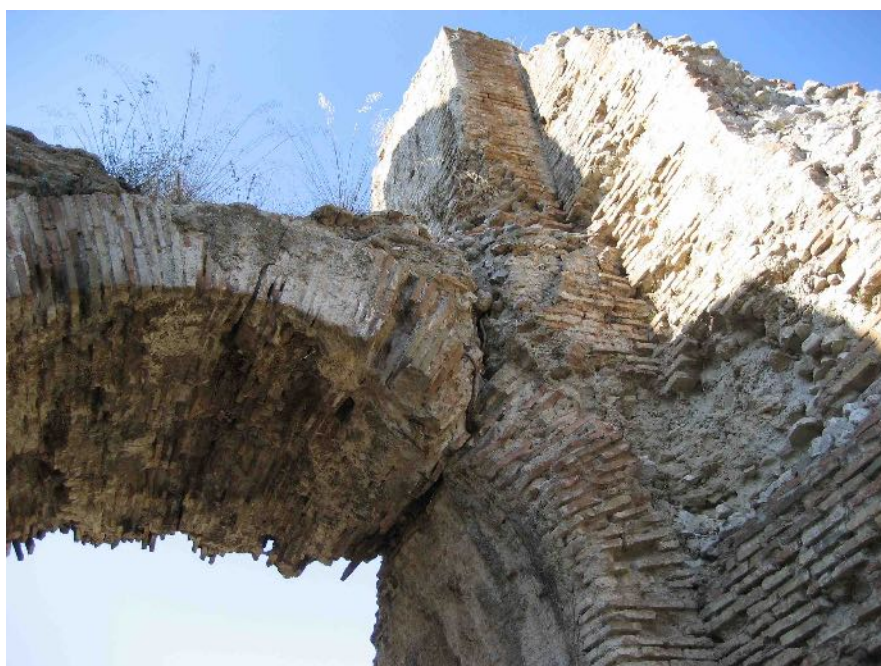
Εικ. 4. Αποκόλληση του μοναδικού σωζόμενου τόξου από τον ένα πεσσό γένεσής του (φωτ. Μ. Μεντζίνη).
