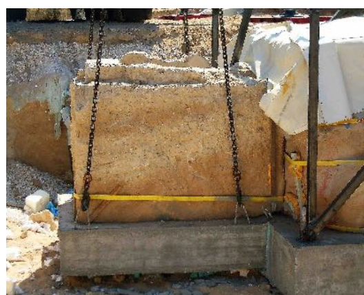
Εικ. 6. Ολοκλήρωση εργασιών δημιουργίας πλατφόρμας (εσχάρας) ανάρτησης του ρωμαϊκού τάφου 313 (φωτ. ΕΦΑΚΟΡ).
