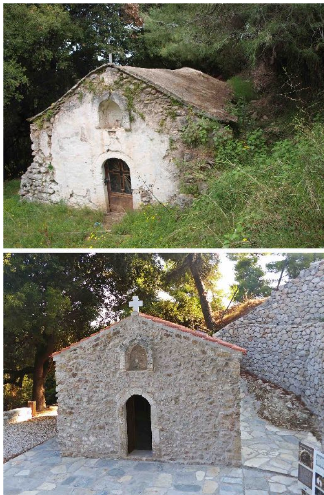
Εικ. 1. Η δυτική όψη του ναού πριν και μετά την αποκατάστασή του και τη διαμόρφωση του περιβάλλοντος χώρου.
