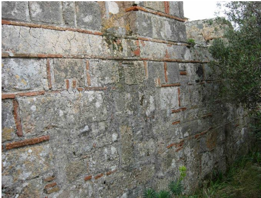
Εικ. 3. Άγιος Νικόλαος Οχιάς. Βόρεια πλευρά, διακρίνεται η ταινία με το εγχάρακτο ρομβοειδές θέμα επάνω στο κονίαμα, πριν τις εργασίες (φωτ. ΕΦΑΛΛΑΚ).
