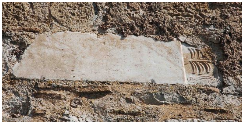
Εικ. 2. Τμήμα αδιάγνωστου αρχιτεκτονικού μέλους (παραστάδας ;) ενσωματωμένο σε πύργο της τρίτης ζώνης οχύρωσης του κάστρου (φωτ. ΕΦΑΚΟΡ).
