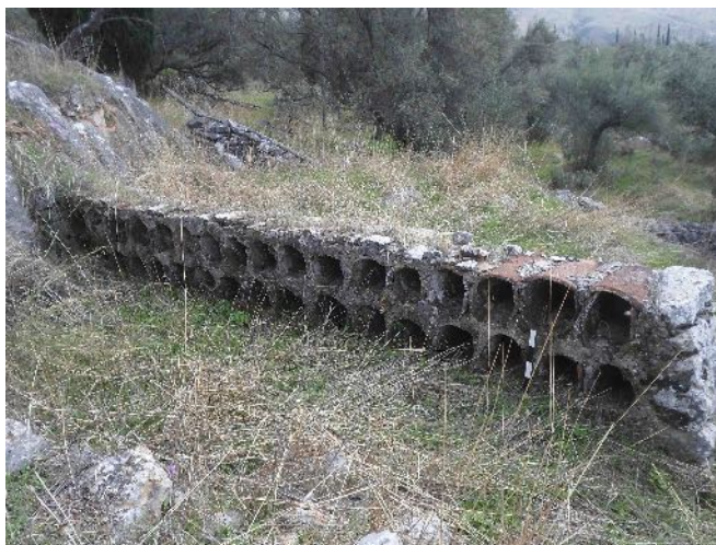
Εικ. 6. Η οπίσθια πλευρά των θυρίδων, διαμορφούμενων από κεραμίδες στέγης, μελισσοκομείου στις Θαλάμες (φωτ. Γ. Μαυροφύδης).
