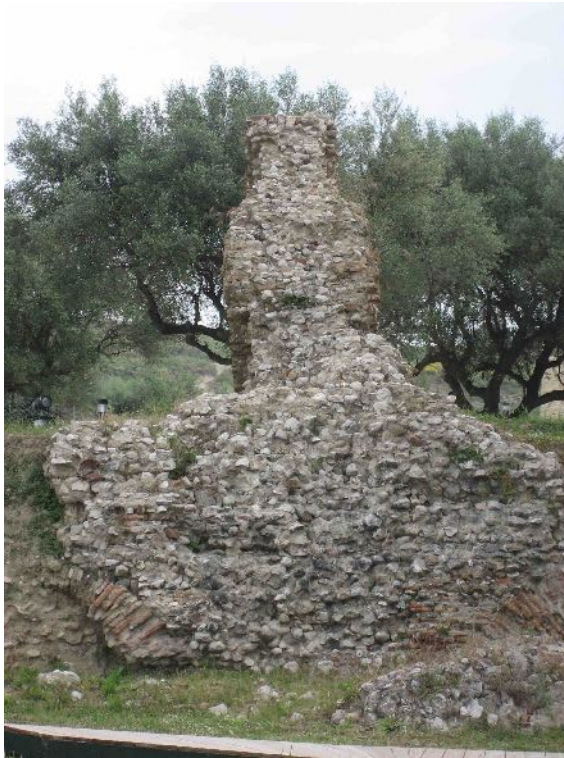
Εικ. 3. Ο τρόπος κατασκευής του λιθοδέματος στο εσωτερικό της κατασκευής (φωτ. Μ. Μεντζίνη, Αρχείο ΕΦΑΑΧΑ).
