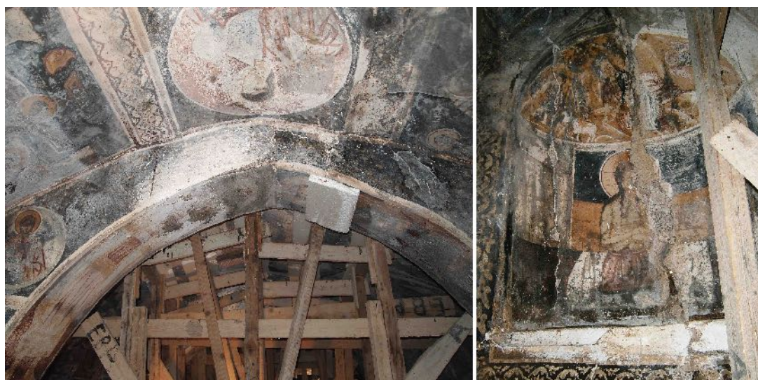
Εικ. 2. α) Άποψη του εσωτερικού του ναού με τις υποστυλώσεις και β) η κόγχη της Πρόθεσης πριν τις εργασίες.
