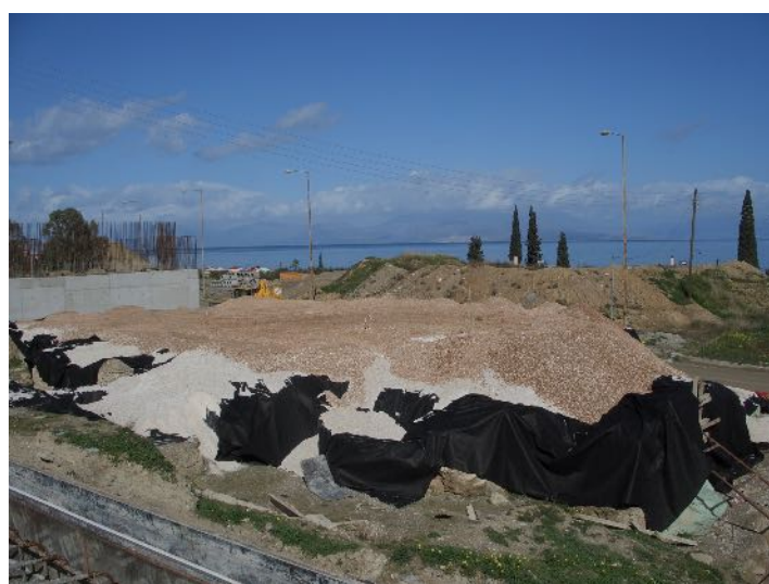
Εικ. 8. Το λουτρό μετά την προσωρινή κατάχωσή του (φωτ. ΕΦΑΚΟΡ).
