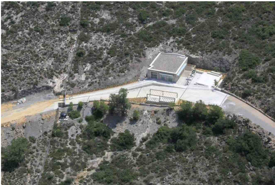
Εικ. 9. Κάστρο Γερακίου. Είσοδος αρχαιολογικού χώρου και κτήριο υποδοχής επισκεπτών από δυτικά μετά τις εργασίες (φωτ. Β. Γεωργιάδης, Αρχείο ΕΦΑΛΑΚ).
