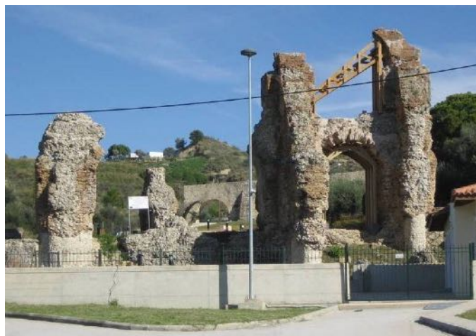
Εικ. 7. Άποψη του ρωμαϊκού υδραγωγείου και του αρχαιολογικού χώρου μετά το πέρας των εργασιών. Διακρίνονται οι νέες λιθοδομές για την εξασφάλιση των πεσσών (Αρχείο ΕΦΑΑΧΑ, φωτ. Μ. Μεντζίνη).
