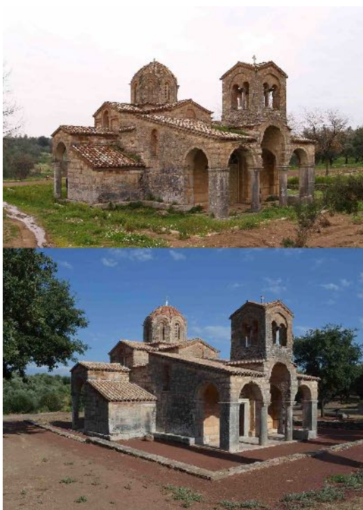
Εικ. 7. Αποκατάσταση Ζωοδόχου Πηγής Σαμαρίνας (φωτ. ΕΦΑΜΕΣ).
