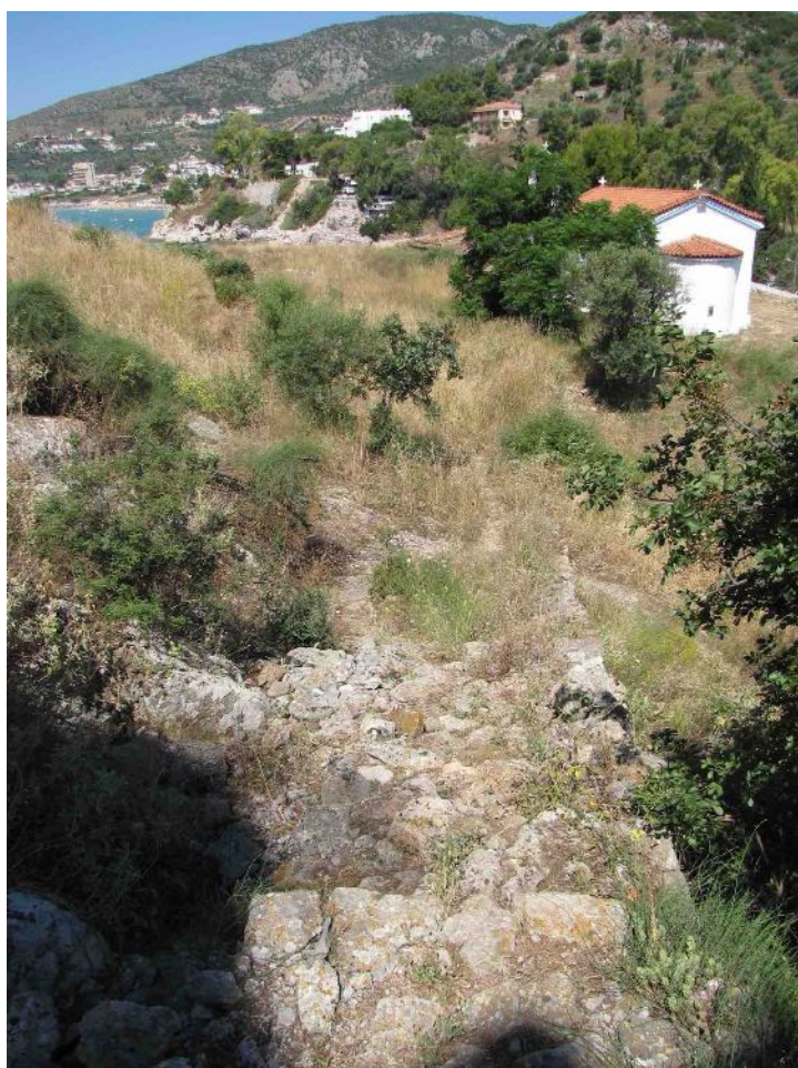
Εικ. 4. Η πρόσβαση προς την Ακρόπολη πριν την έναρξη των εργασιών. Άποψη από τα ανατολικά (Αρχείο ΕΦΑΑΡΓ).
