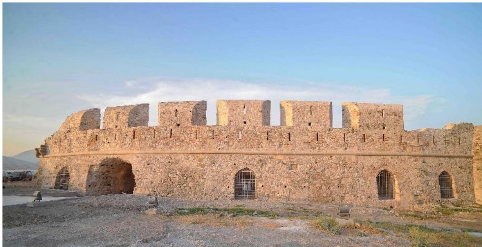
Εικ. 3. Φρούριο Ρίου. Βόρειος Ενετικός Προμαχώνας μετά την ολοκλήρωση του έργου αποκατάστασης (φωτ. Αρχείο ΕΦΑΑΧΑ).
