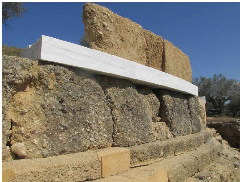
Εικ. 10. Άποψη της ΝΑ ενότητας του αναστηλωμένου μνημείου (φωτ. Γ. Ορεστίδης).
