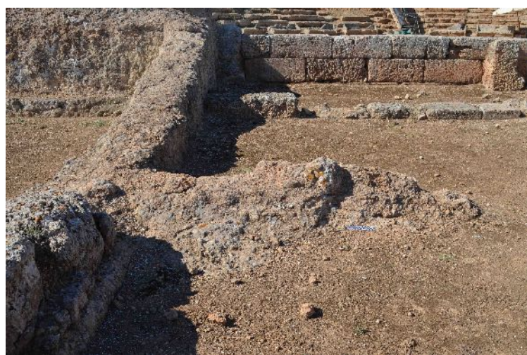
Εικ. 6. Έντονη αποσάθρωση: τμήμα σκηνικού οικοδομήματος του μνημείου (φωτ. ΕΦΑΚΟΡ).
