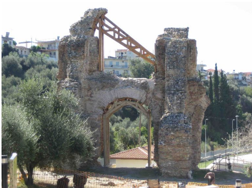
Εικ. 8. Υποστύλωση του σωζόμενου τόξου με μεταλλικό θολότυπο εδραζόμενο σε βάσεις από σπλισμένο σκυρόδεμα. Διακρίνεται το ξύλινο δικτύωμα της αντιστήριξης της απώλειας του εναπομείναντος τμήματος του άνω τόξου και η περίδεσή του με συρματόσχοινα (φωτ. Μ. Μεντζίνη).
