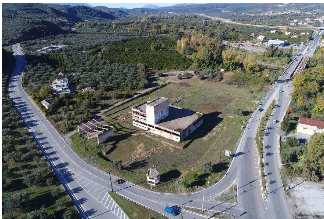
Εικ. 10. Το οικόπεδο του Νέου Αρχαιολογικού Μουσείου Σπάρτης στην είσοδο της πόλης (φωτ. ΕΦΑΛΑΚ).
