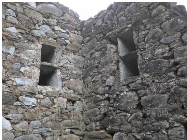
Εικ. 2. Διώροφες κυψέλες του τύπου «ντουλάπι» στον τοίχο του ελαιοτριβείου της Μονής Σωτήρος στο φαράγγι Βυρού. Εσωτερική πλευρά (φωτ. Γ. Μαυροφρύδης).
