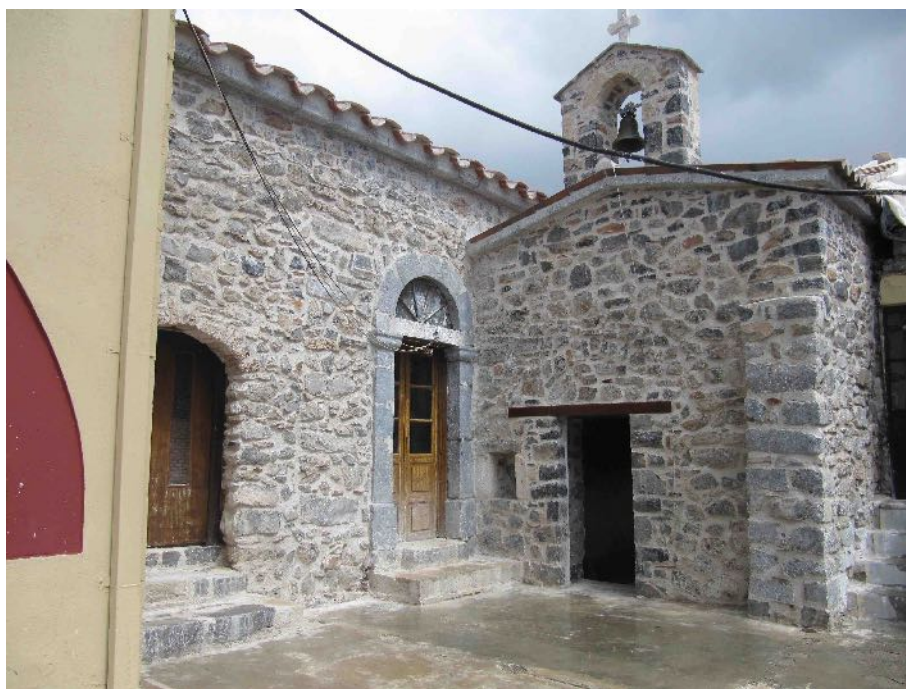
Εικ. 8. Μονή Επάνω Χρέπας. Η είσοδος του καθολικού και το παρεκκλήσιο μετά την αποκατάσταση (φωτ. ΕΦΑΑΡΚ).
