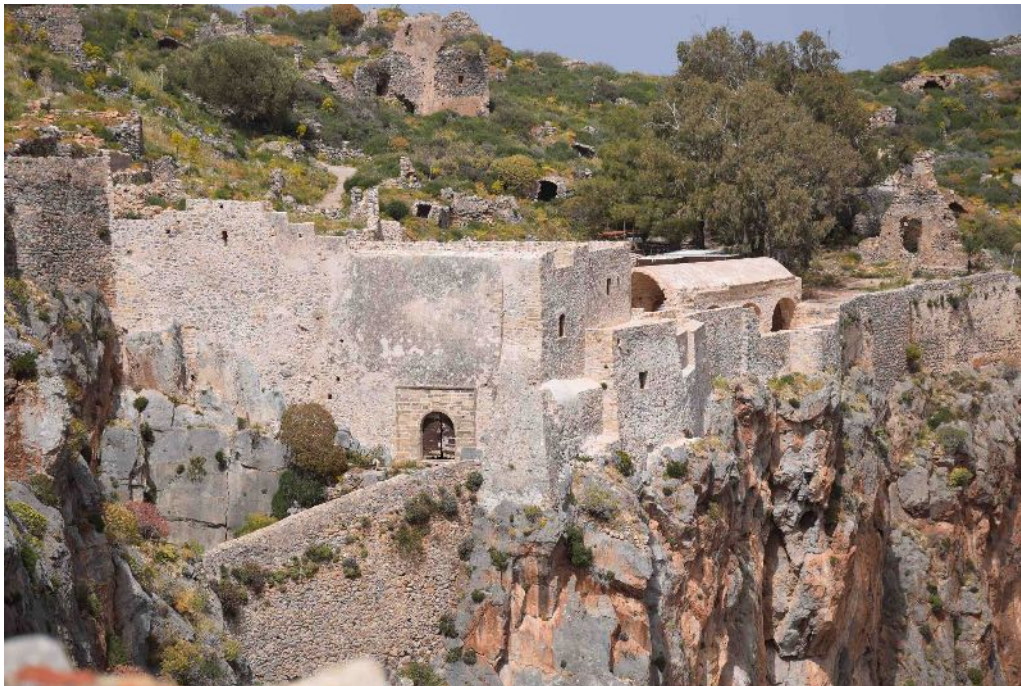
Εικ. 2. Συγκρότημα κεντρικής πύλης μετά την ολοκλήρωση των εργασιών (Αρχείο ΕΦΑΛΑΚ, φωτ. Π. Σκάγκου).
