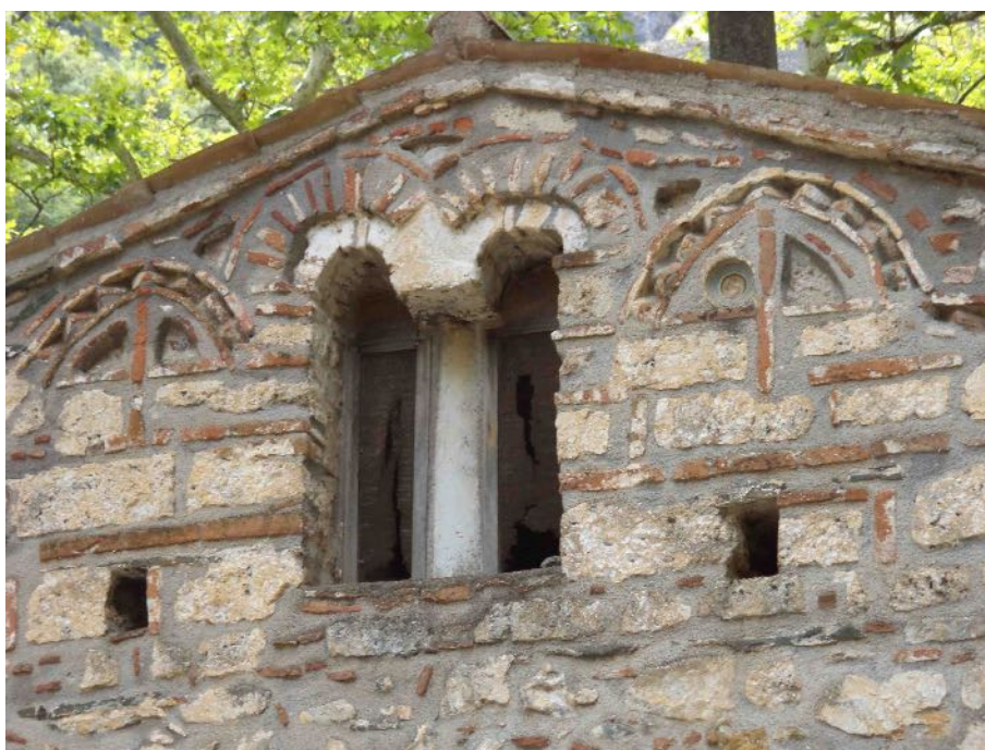
Εικ. 2 Λεπτομέρεια από το δίλοβο παράθυρο του δυτικού τοίχου (ναός του Τιμίου Προδρόμου, Τρύπη Ταΐγету) (φωτ. ΕΦΑΛΑΚ).
