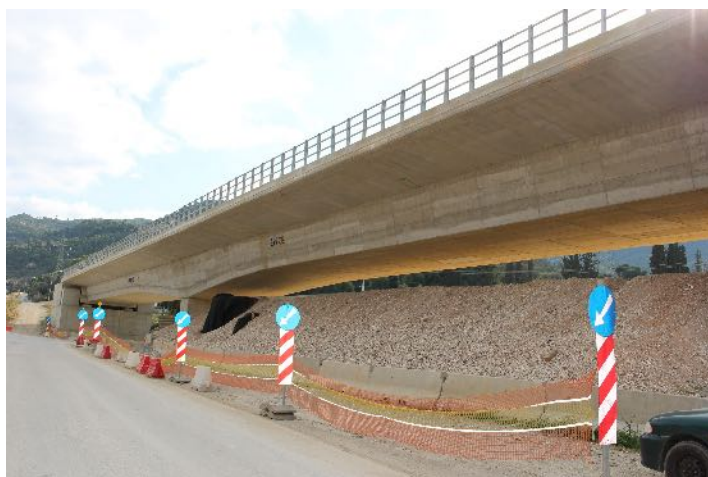
Εικ. 7. Η γέφυρα που υπέρκειται του λουτρού (φωτ. ΕΦΑΚΟΡ).
