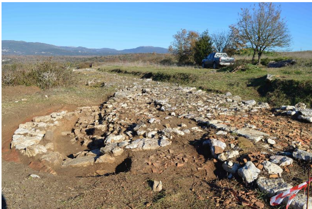
Εικ. 6. Κυπαρίσσια. Ημικυκλικός πύργος του τείχους (φωτ. ΕΦΑΑΡΚ).
