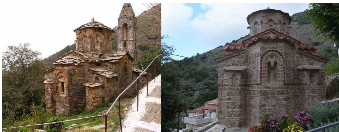
Εικ. 18. Αποκατάσταση Αγίου Πέτρου Καστάνιας (φωτ. ΕΦΑΜΕΣ).
