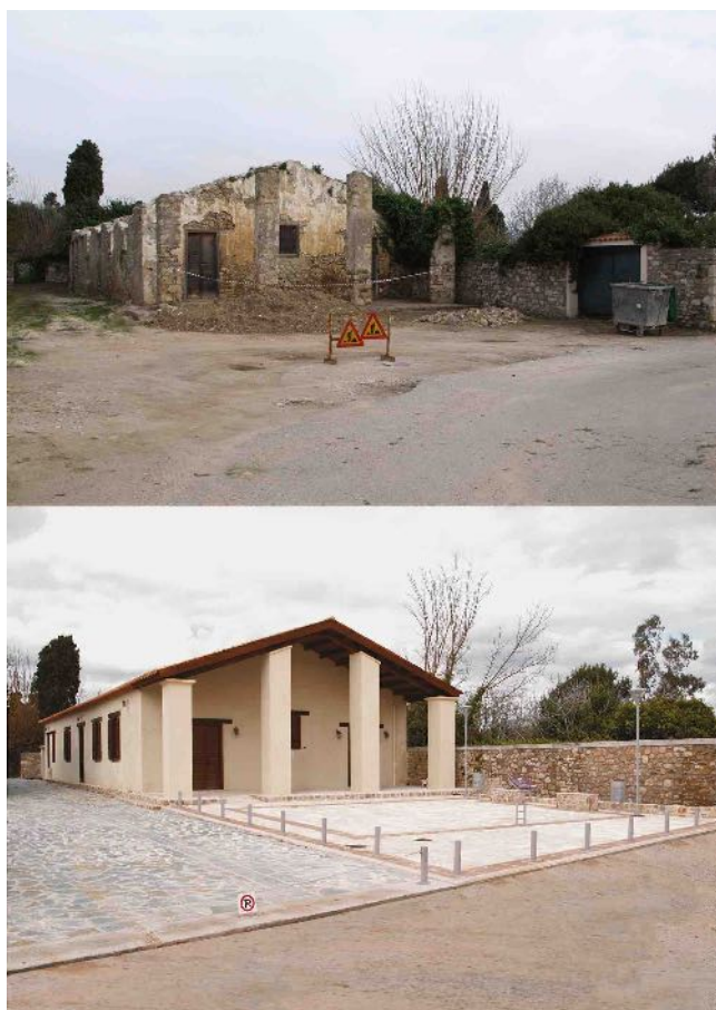
Εικ. 17. Αποκατάσταση Καποδιστριακού Σχολείου Μεθώνης (φωτ. ΕΦΑΜΕΣ).
