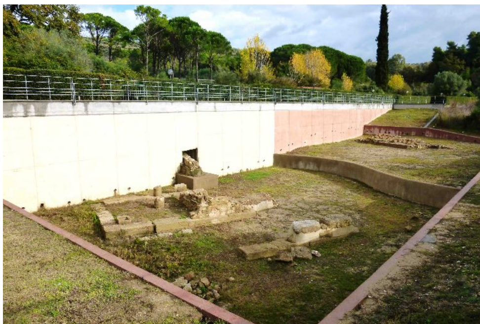
Εικ. 5. Αρχαιολογικός Χώρος Ολυμπίας: το ιερό της Δήμητρας Χαμύνης μετά την ολοκλήρωση του έργου «Προστασία και ανάδειξη του Ιερού της Δήμητρας Χαμύνης και του αναλήμματος των Θησαυρών του Κρονίου Λόφου στην Αρχαία Ολυμπία», άποψη από ΝΔ (Αρχειο ΕΦΑΗΛ).
