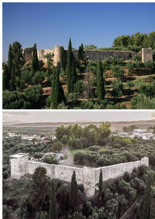
Εικ. 9. Αποκατάσταση ανατολικού τμήματος τειχών Κάστρου Ανδρούσας (φωτ. ΕΦΑΜΕΣ).
