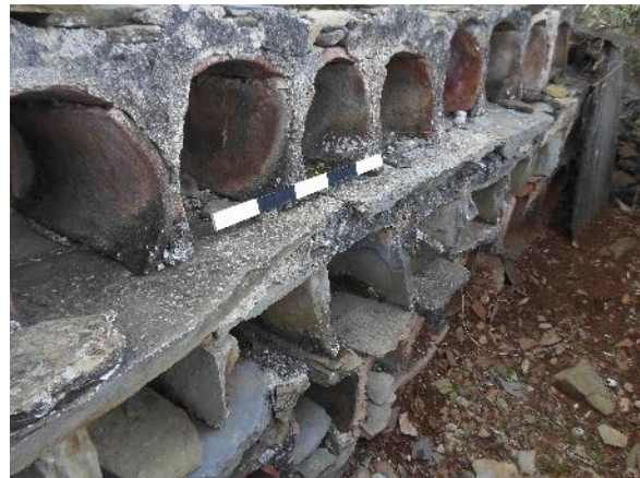
Εικ. 8. Τμήμα της οπίσθιας πλευράς μελισσοκομείου στην Τραχήλα (φωτ. Γ. Μαυροφρύδης).
