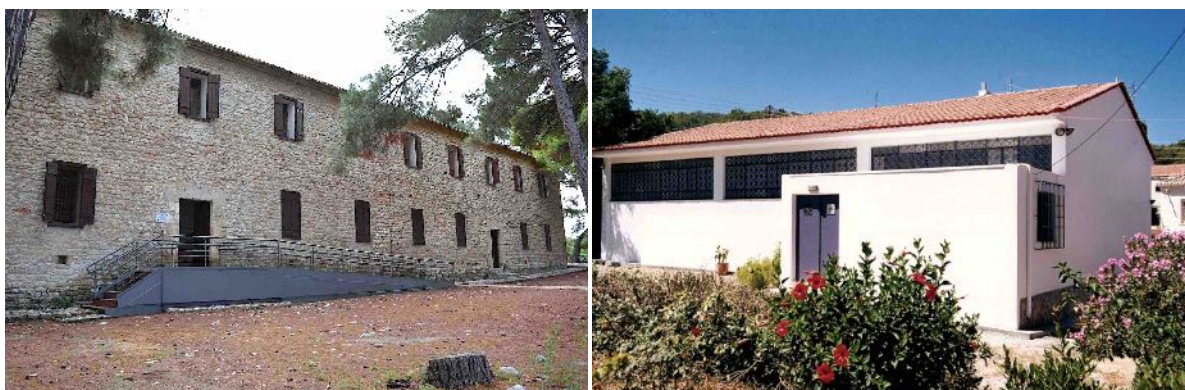
Εικ. 1. Το κτήριο Μαιζώνος όπου μετεγκαταστάθηκε το Αρχαιολογικό Μουσείο Πύλου (αριστερά) και το Αντωνοπούλειο κτήριο (πρώην Αρχαιολογικό Μουσείο Πύλου) (δεξιά) (φωτ. ΕΦΑΜΕΣ).
