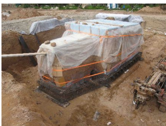
Εικ. 5. Διάνοιξη οπών κάτω από το δάπεδο του τάφου 536, για την τοποθέτηση μεταλλικού σωλήνα (φωτ. ΕΦΑΚΟΡ).
