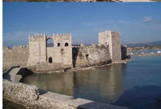
Εικ. 16. Αποκατάσταση Κάστρου Μεθώνης (φωτ. ΕΦΑΜΕΣ).
