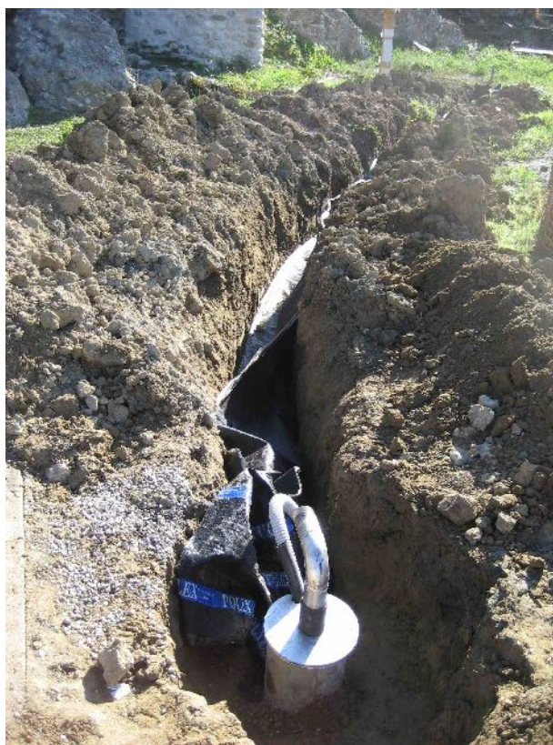
Εικ. 9. Εκσκαφή τάφρου αποστράγγισης και τοποθέτηση εντός γεωτρήματος αντλίας στα κατάντη του μνημείου (φωτ. Μ. Μεντζίνη).
