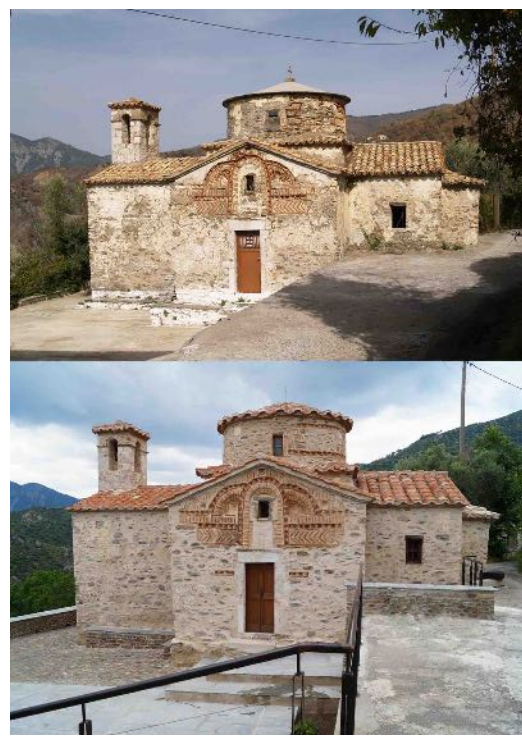
Εικ. 8. Αποκατάσταση Αγίου Νικολάου Μεσόρουγας Αλαγονίας (φωτ. ΕΦΑΜΕΣ).
