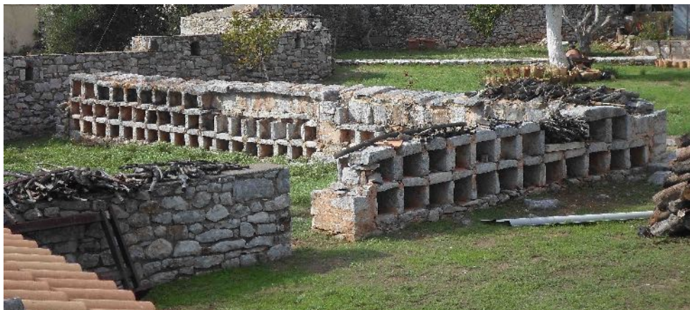
Εικ. 9. Λιθόκτιστο μελισσοκομείο σε σχήμα Γ στην Αρεόπολη. Διακρίνονται ορισμένα εμπρόσθια πώματα θυρίδων του (φωτ. Γ. Μαυροφρύδης).
