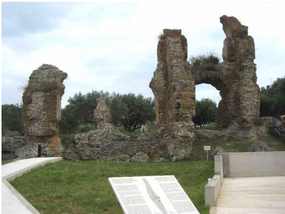
Εικ. 1. Γενική άποψη του μνημείου από τον Νότο πριν την εφαρμογή της αποκατάστασης (φωτ. Μ. Μεντζίνη).
