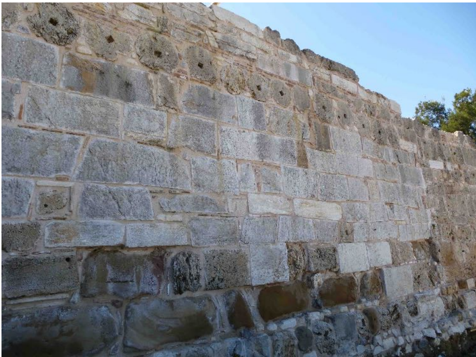
Εικ. 2. Κάστρο Πάτρας. Εξωτερική παρειά των βορείων τειχών μετά την αποκατάσταση (φωτ. Αρχείο ΕΦΑΑΧΑ).
